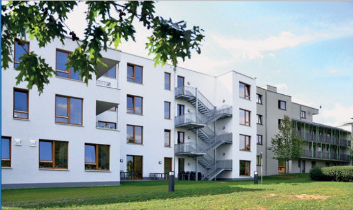
Teilansicht von Nordost mit angrenzendem Altbau
