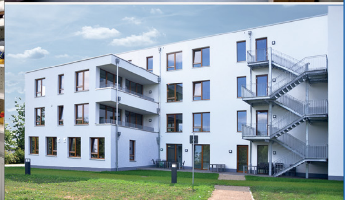
Teilansicht von Nordwest mit Loggien und Fluchttreppenhaus
