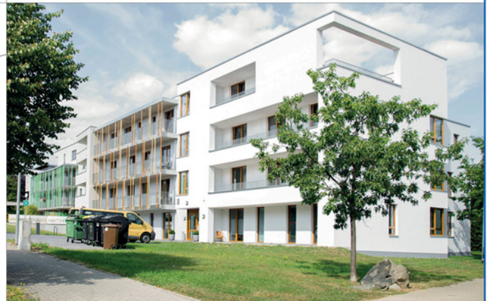
3. Obergeschoss – Teilansicht Dachterrasse Ostseite
