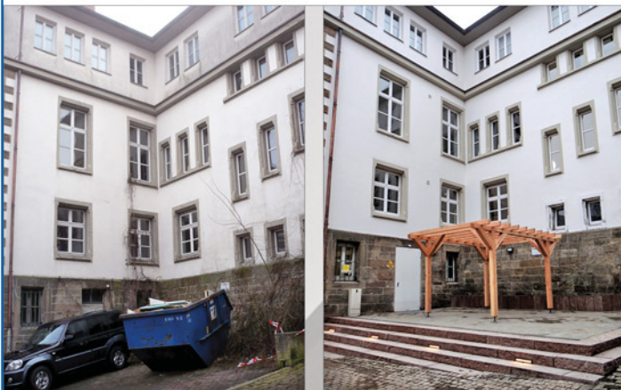
Teilansicht Nordwest - vorher, nachher
