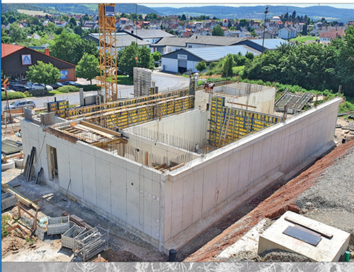
Teilansicht Baustelle von Nordwest – Baufortschritt
