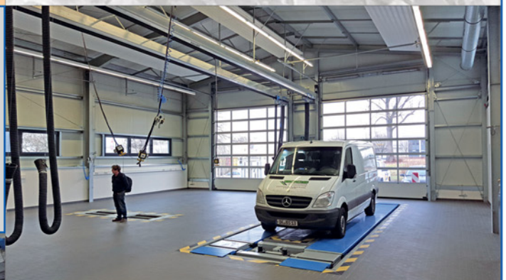
Innenansicht mit Hebebühne und Bremsenprüfstand
