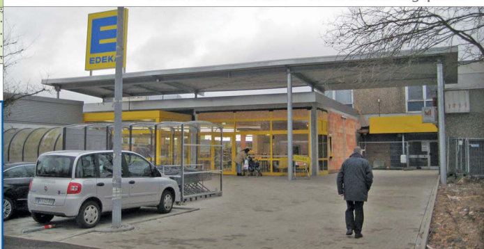
Ansicht von Norden - In der Sanierungsphase
