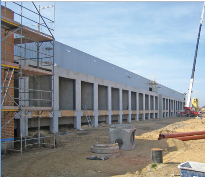
Teilansicht Nord Baustelle - Ladebühnen
