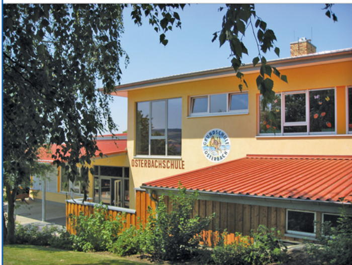
Grundschule Osterbach – Teilansicht von Osten
