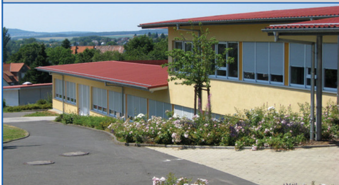
Vordergrund: Grundschule, Hintergrund: Integrierte Sonderschule
