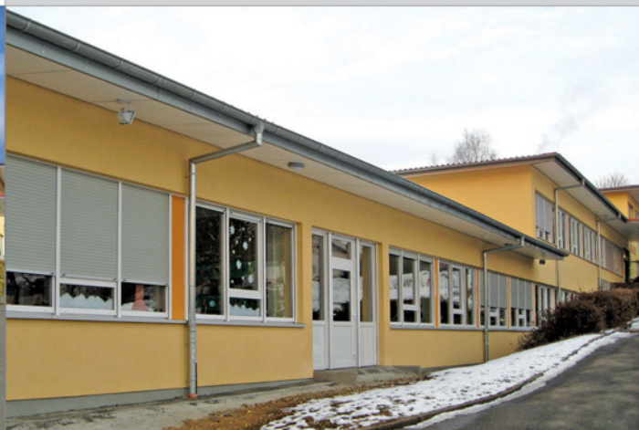
Außenfassade nach der Sanierung
