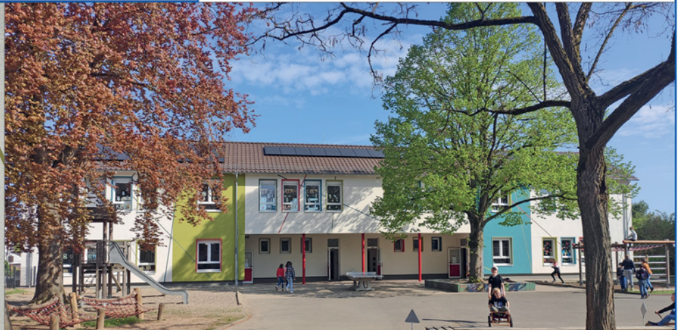
Teilansicht Südseite - Klassentrakt
