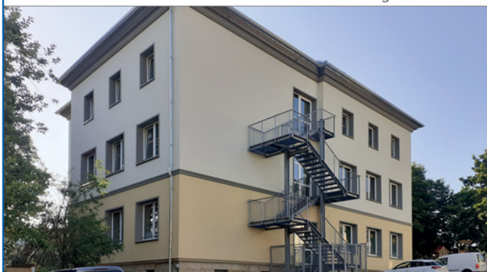
Ansicht von Nordwest - Nach der Fassadensanierung
