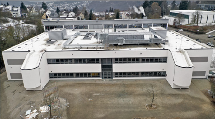
Ansicht von Osten - Nach energet. Fassadensanierung
