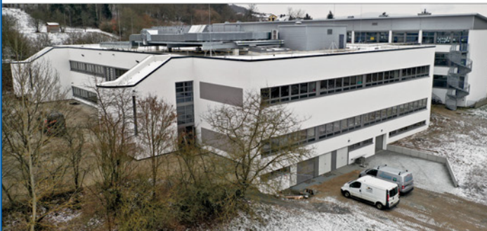
Ansicht von Nordost - Nach energet. Fassadensanierung
