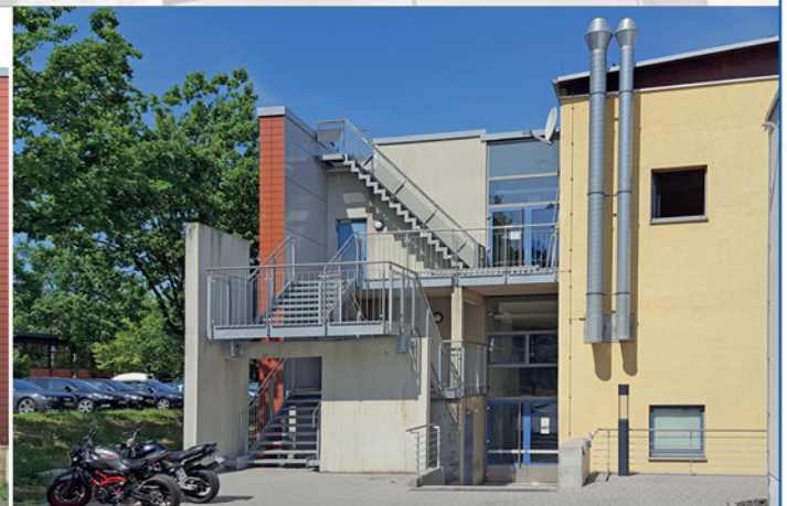
Teilansicht von Osten – Abriss und Neubau Außentreppehaus
