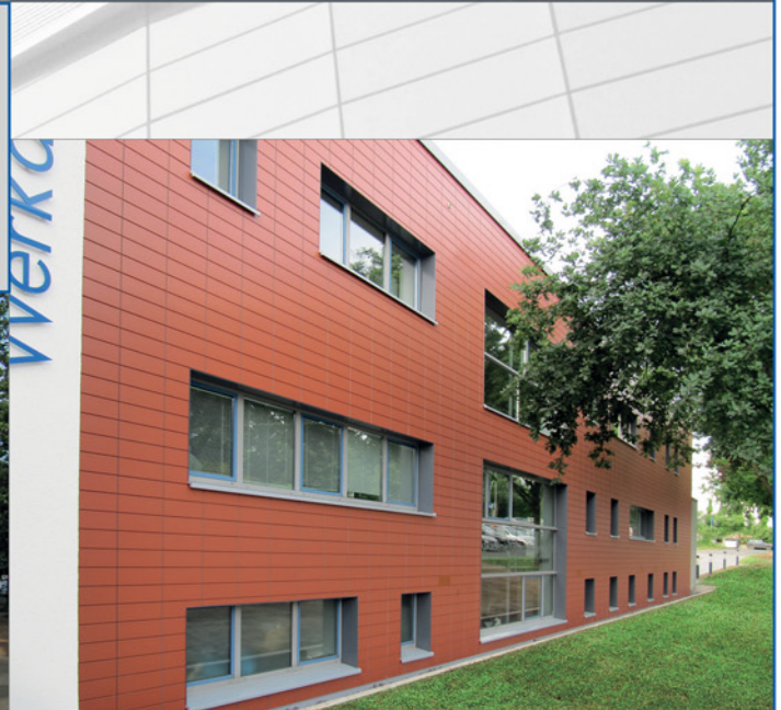
Teilansicht Südfassade gegen Ende der Sanierungszeit
