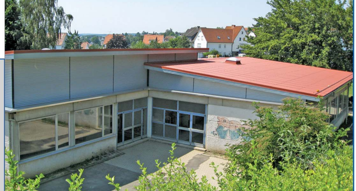
Ansicht von Nord-Ost - Während der Sanierung
