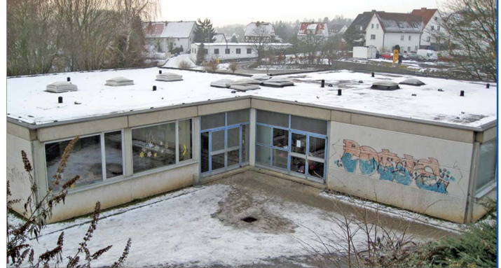
Ansicht von Nord-Ost - Vor der Sanierung
