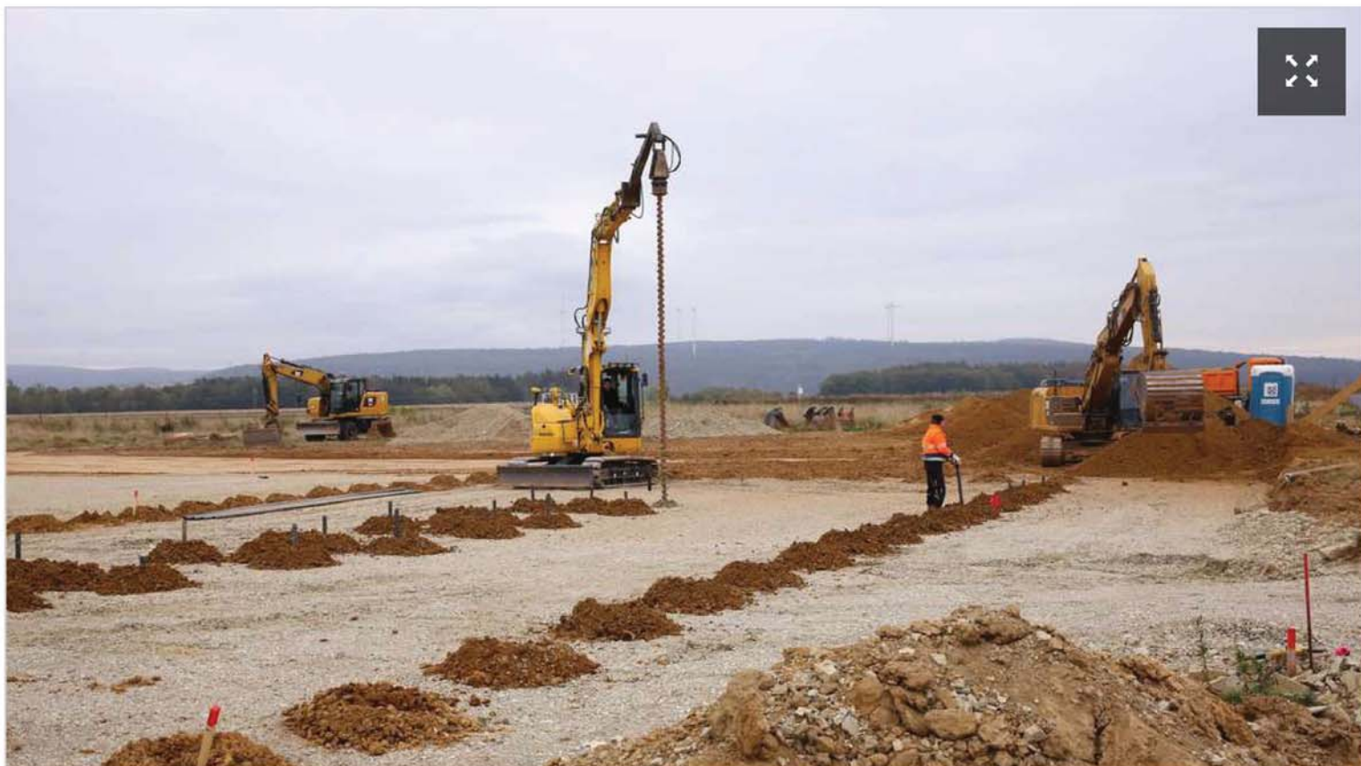
Probebohrungen: Die vorbereitenden Erdarbeiten zum Bau des neuen MGW-Standorts laufen. © Andreas Fischer
