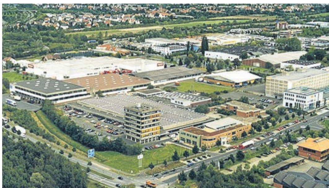
Das alte Berufsbildungszentrum ist Geschichte. Wo einst Werkstatthallen standen, ist ein Innenhof entstanden, um den herum sich Werkstätten und Theorieräume sowie das Internat samt Kantine gruppieren.
