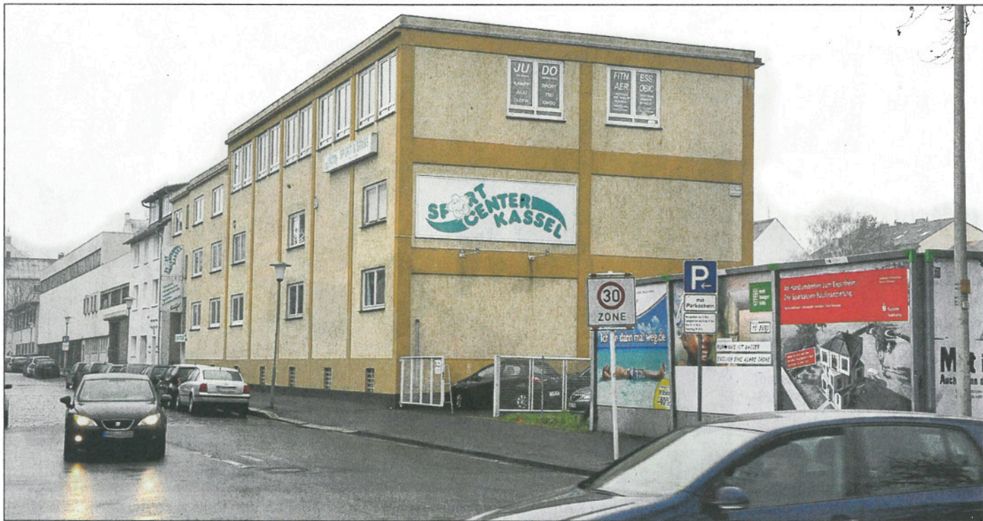
Hier wird bald kräftig investiert: Das Unternehmen Krieger + Schramm will an der Sickingenstraße/Ecke Wolfhager Straße für drei Mio. Euro eine Häuserzeile mit 33 Studentenwohnungen errichten. Das Gebäude, in dem derzeit das Sport-Center ist, und das Nachbarhaus werden saniert und umgebaut.
