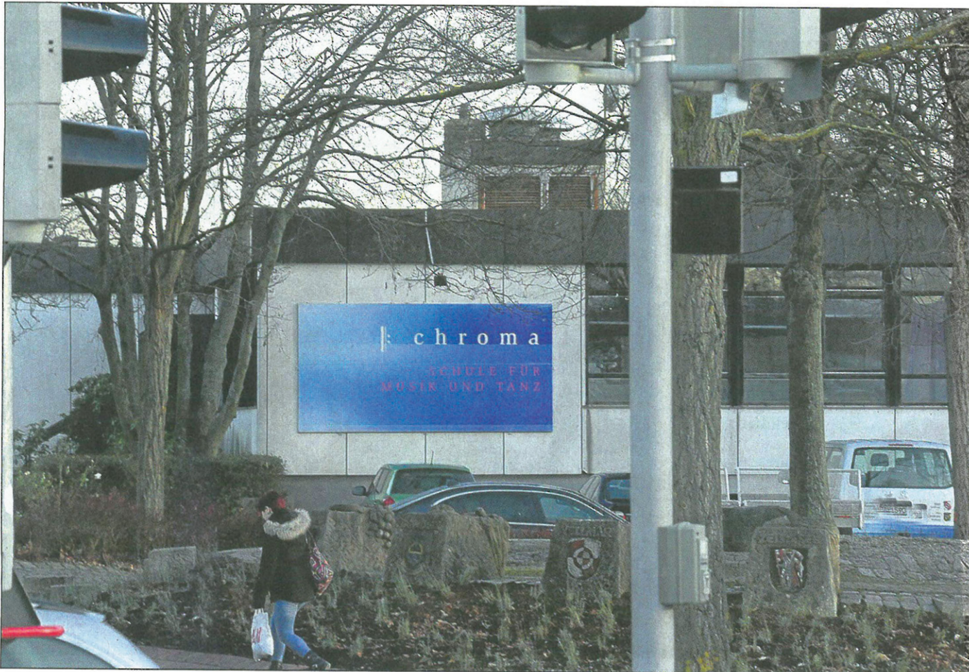
Hier rollen bald Bagger: Der marode Flachbau der Musikschule Chroma wird nächstes Jahr abgerissen und durch einen Neubau in Leichtbauweise ersetzt. Links, wo jetzt Bäume zu sehen sind, wird eine großzügige Treppe den Eingangsbereich bilden. Fotos: Dilling
