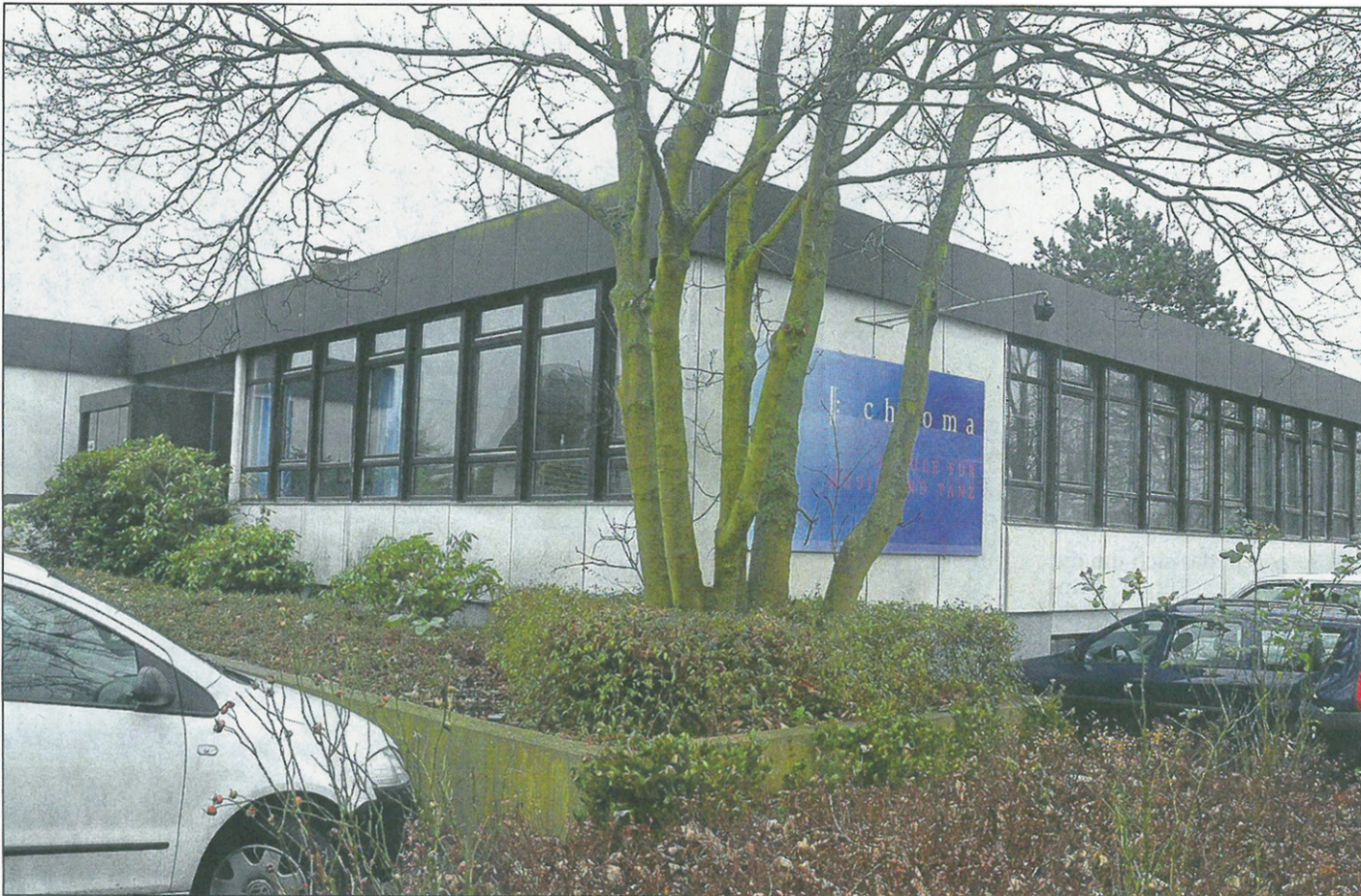
Musikschule erhält neues Gesicht: Nach dem Abriss wird der Eingang (links hinten im Bild) in die Mitte des Gebäudetrakts, in Höhe des Baums (im Vordergrund), verlegt. Er soll eine breite Treppe erhalten.
