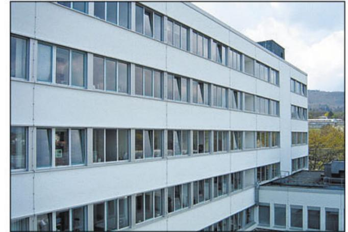
So präsentiert sich die Fassade nach der Sanierung: Durch die stärkere Betonung der Fensterbänder (durchgehendes oberes Profil, Fensterbänke ebenfalls durchlaufend) erscheint die Fassade deutlich geordneter. Die neuen pastellgrünen Öffnungsflügel beziehen sich farblich auf die bereits sanierten Neubauten. Ein energiesparendes Wärmedämmverbundsystem erzielt bessere Dämmwerte.
