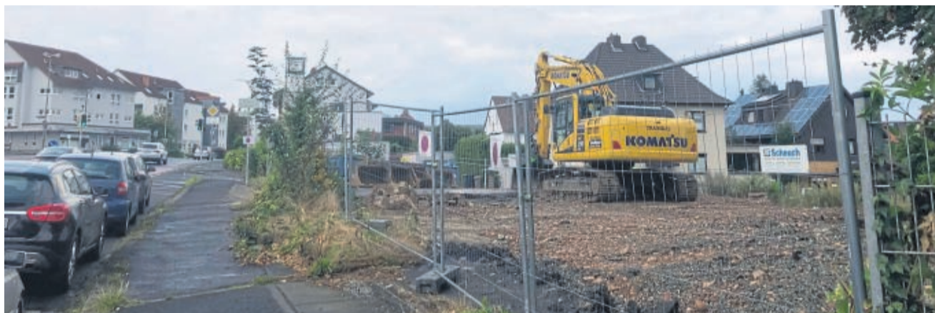
Lag lange Zeit brach: Auf der Fläche an der Loßbergstraße/Haferpfad entsteht der Neubau.
