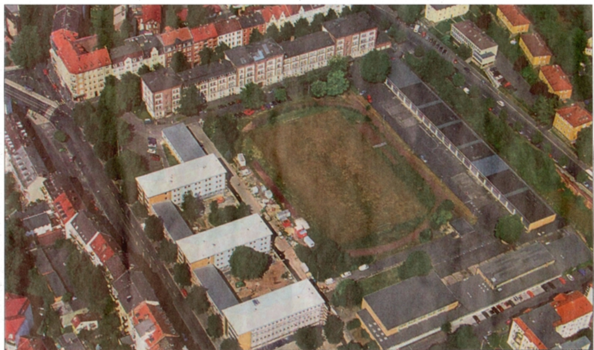
Das Gelände aus der Luft: Auf dem ehemaligen Areal der Bereitschaftspolizei zwischen Friedrich-Ebert-Straße (links) und Breitscheidstraße (rechts) im Vorderen Westen soll ein neues Stadtquartier entstehen. ARCHIVFOTO: HERZOG
