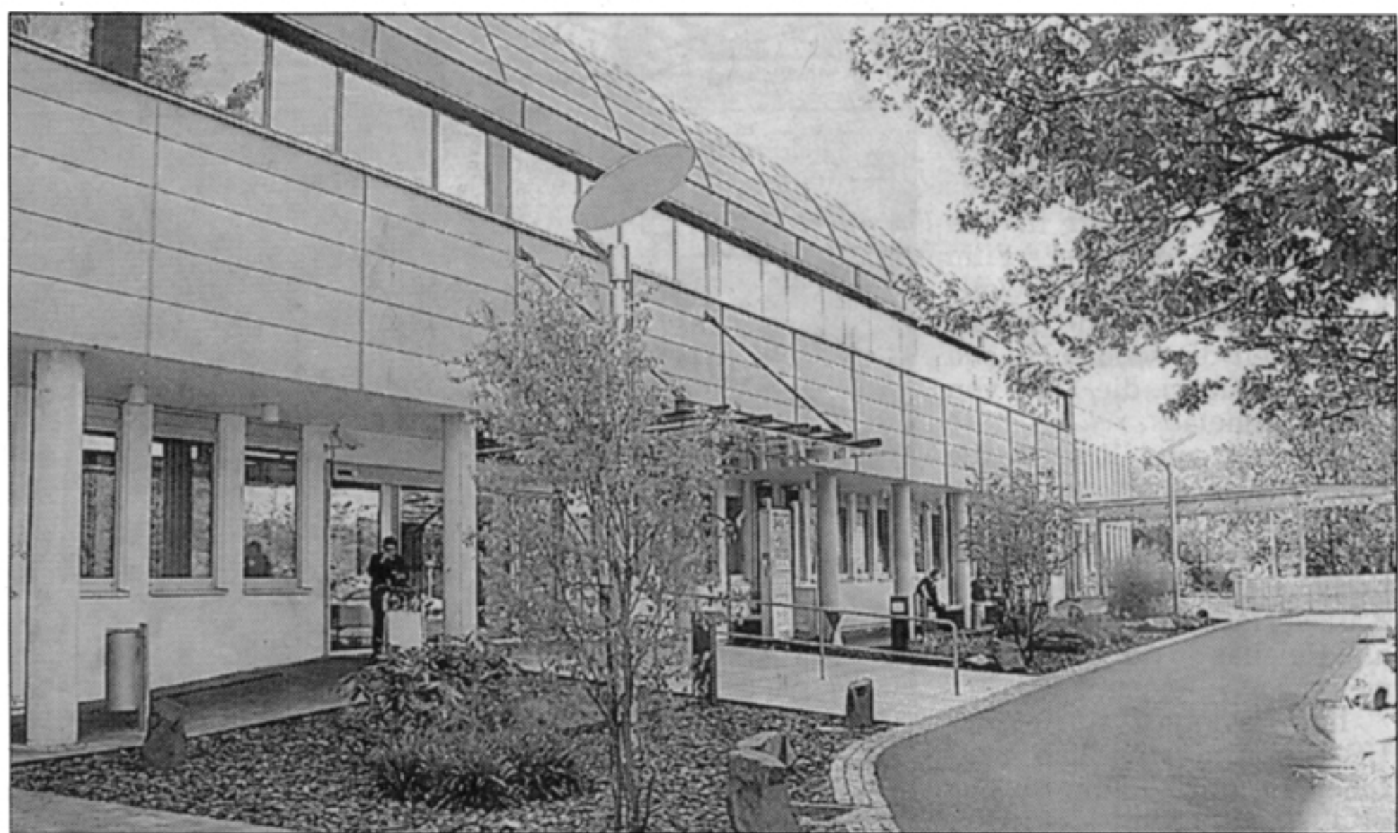
Vor kurzem fertig gestellt: Neubau für die Orthopädische Klinik in Kassel.
